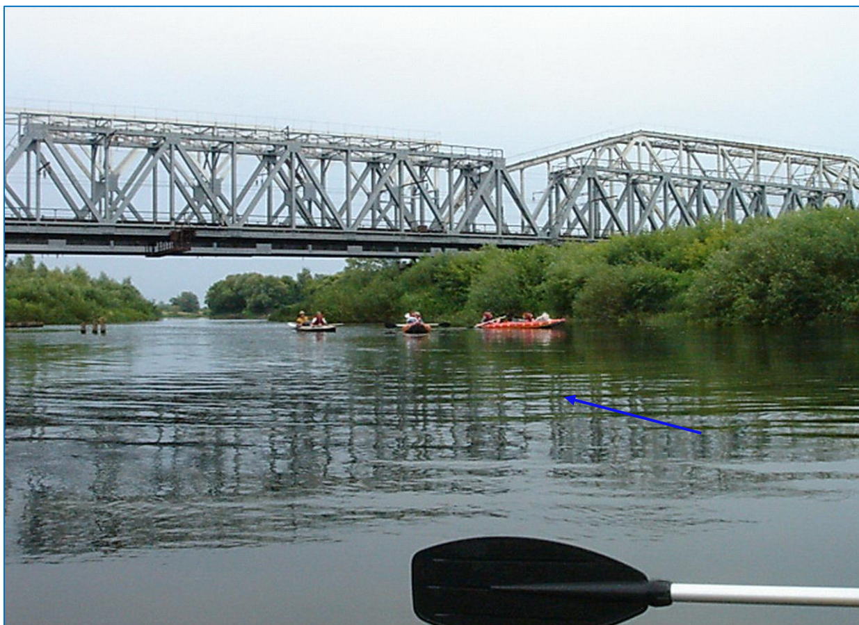
Фото 29. Пройшли під залізничним мостом
