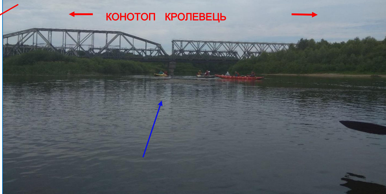
Фото 25. Залізничний міст – велика споруда
