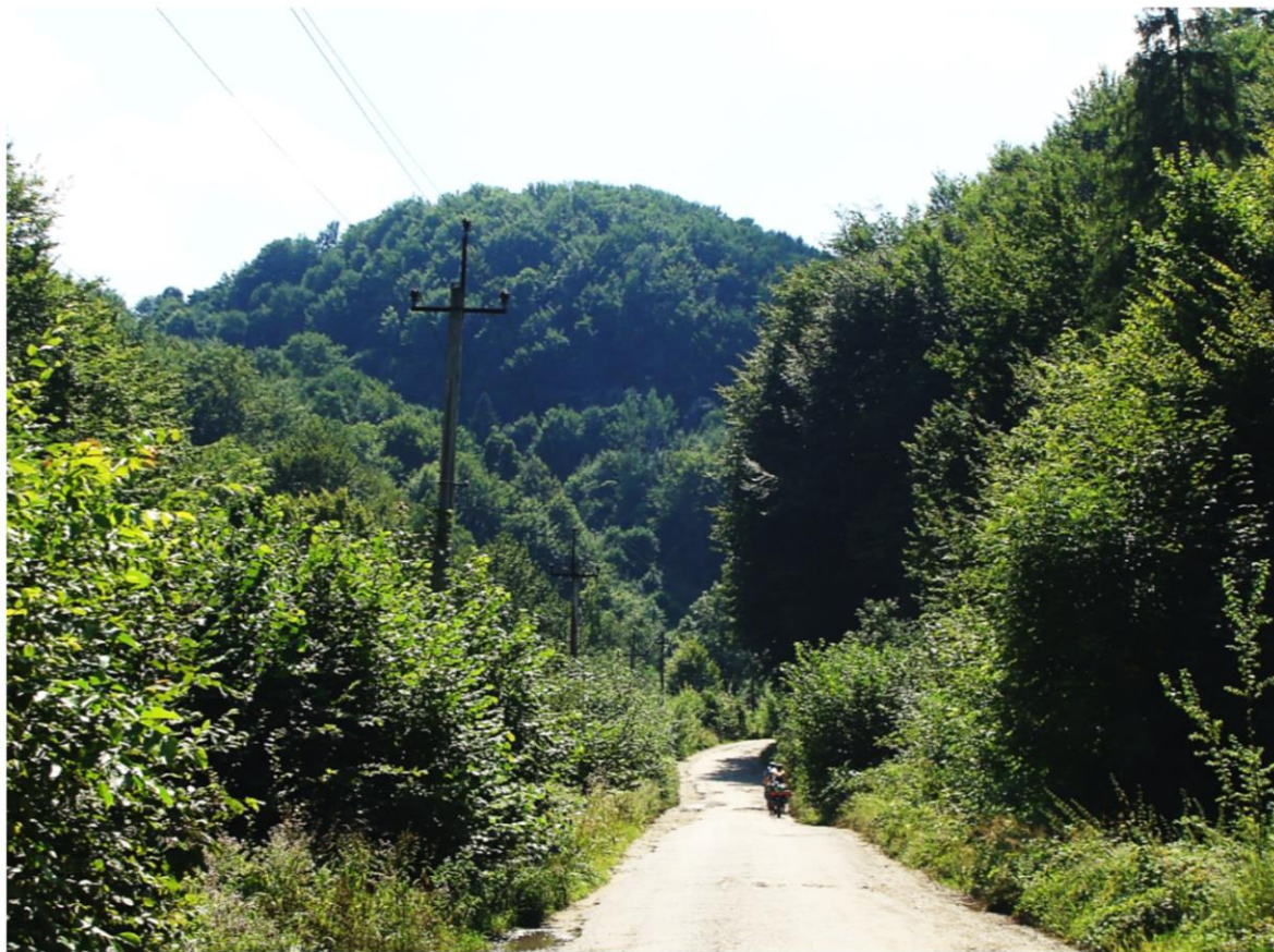
Фото 74. На невеликих ділянках покриття залишилося цілим
