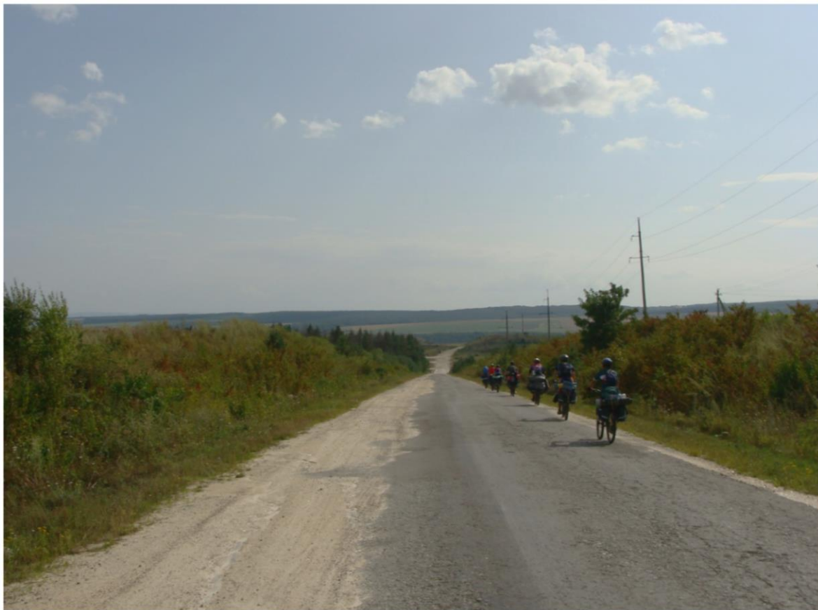
Фото 27. Асфальтоване покриття до с. Шишківці майже зруйноване
