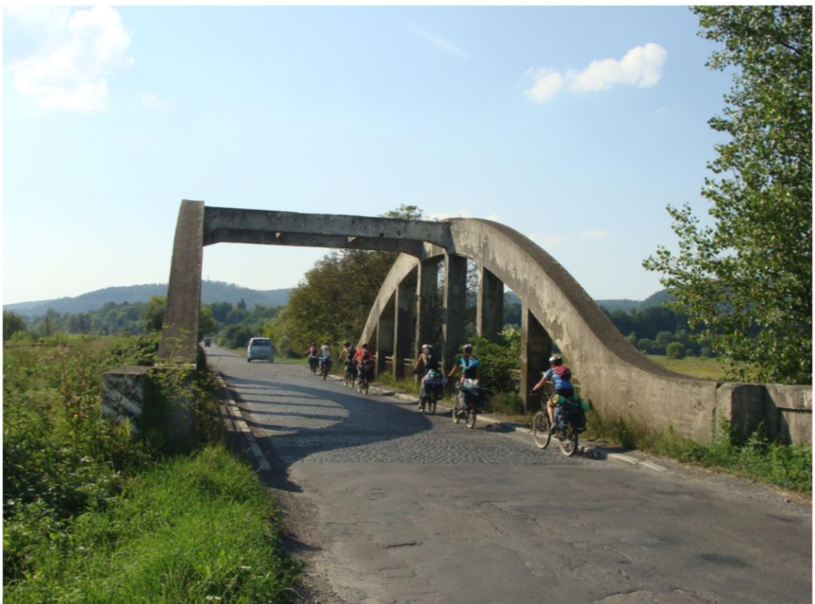
Фото 161. Їдемо мостом через р. Апшиця
