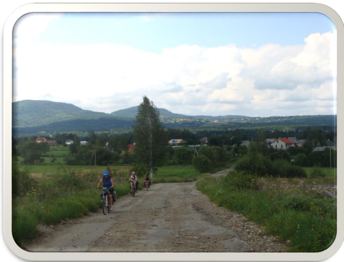
Фото 198. Зруйнована асфальтована дорога вгору з Яблуньки до с. Кричка
