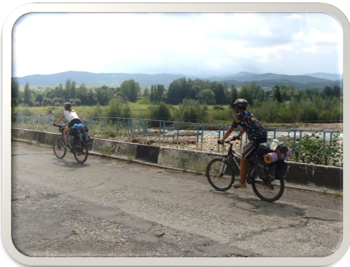
Фото 197. Міст через р. Бистриця Солотвинська
