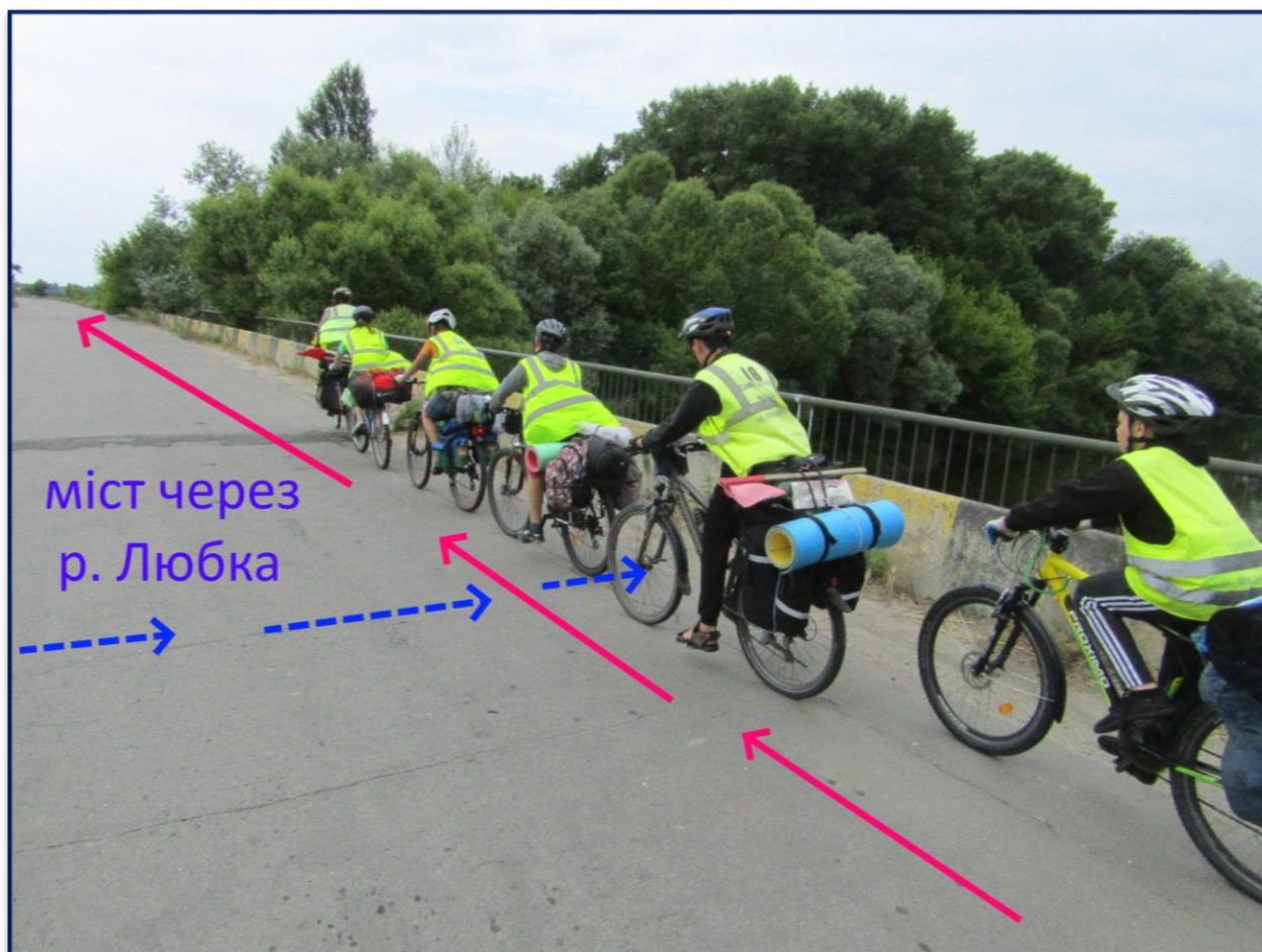
Фото 5.2. Міст через р. Любка
