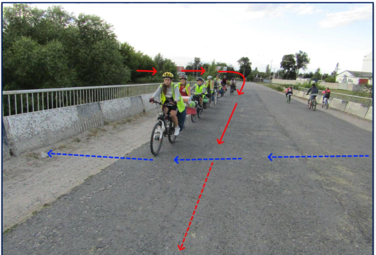
Фото 3.8. Міст через р. Сейм (околиця м. Путивль)
