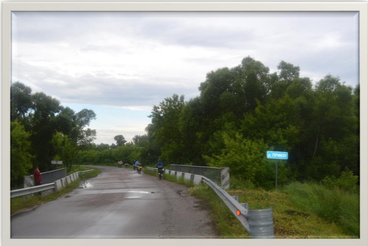
Фото 45. Міст через р. Прикіл
