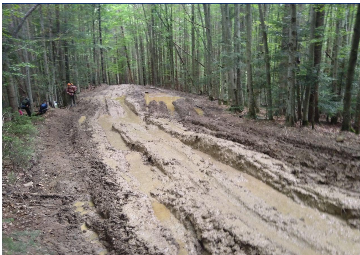
Фото 60. Дорога розбита машинами після дощу
