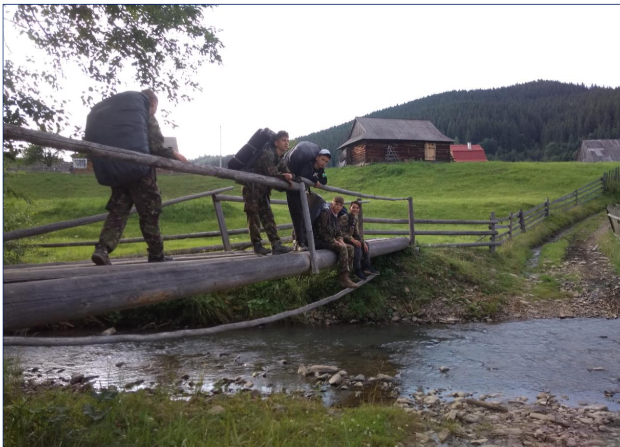
Фото 50. Місток через р. Гропинець
