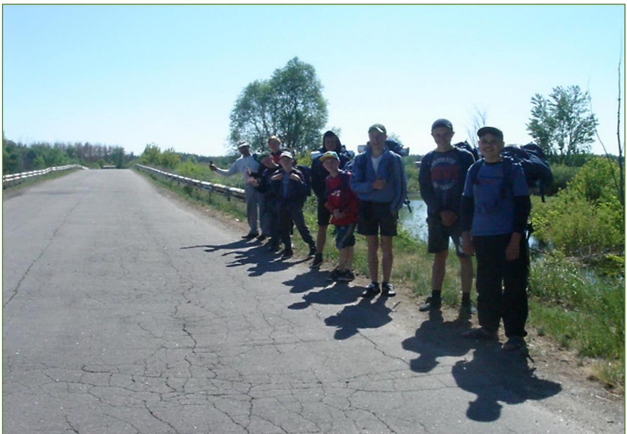
Фото 45. Автомобільний міст через річку Єзуч
