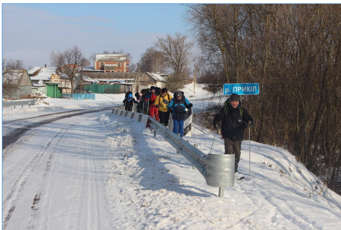
Фото 10. Міст через р. Прикіл
